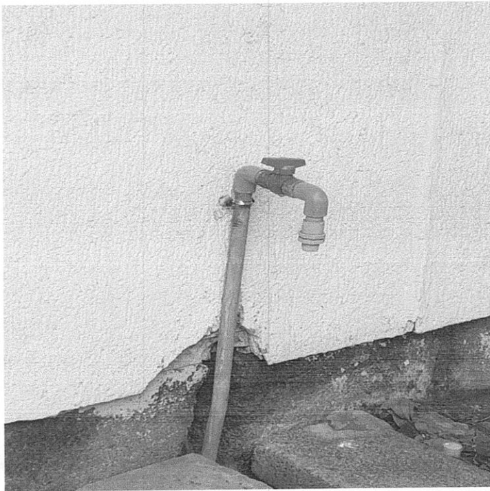
Reparación de la misma e instalación llave de jardín
